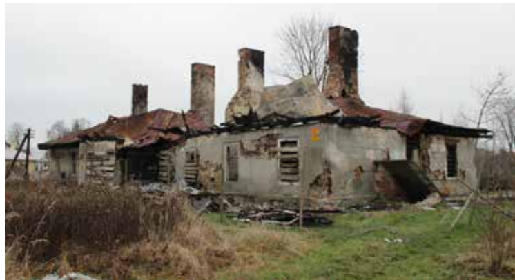
Ilustracja 14. Drewniany dwór zniszczony w wyniku pożaru, fot. B. Podubny, archiwum NID OT w Rzeszowie
