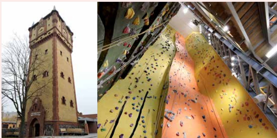
Ilustracja 23. Wieża ciśnień w Kościanie z zaaranżowaną we wnętrzu ścianą wspinaczkową, fot: B. Hyczo, archiwum firmy Autograf
