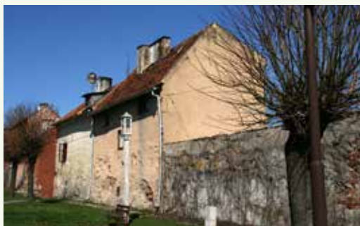
Ilustracja 15. Dobre Miasto, domy przy ul. Sowińskiego, widok od południowego zachodu, stan przed remontem, fot. I. Liżewska, archiwum NID
