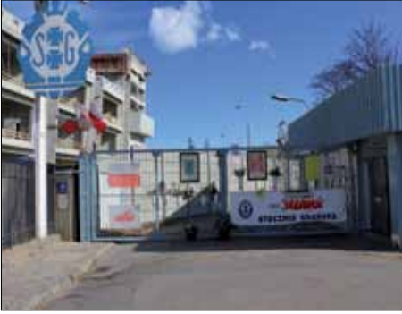
Fig. 3. | Brama nr 2 przed wymianą na obecną / The gate 2 before the change / © Photo: Dorota Nieznalska
