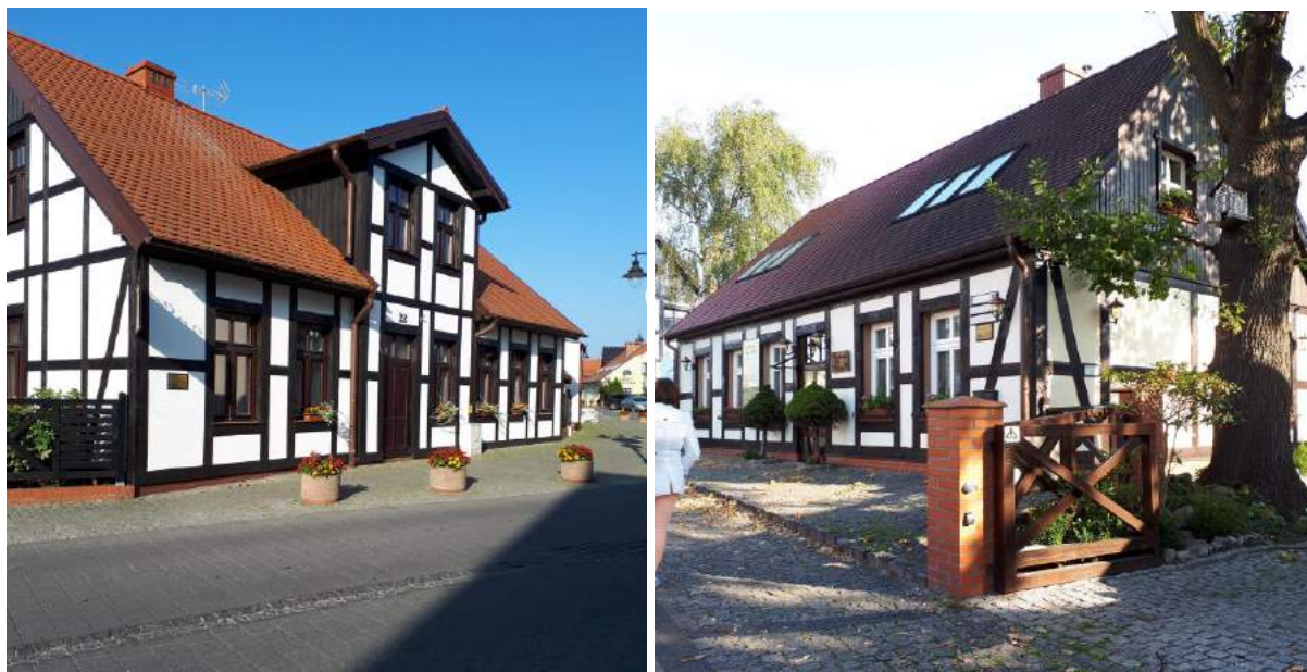
Budynki szachulcowe w Ustce. Fot. AJS.
