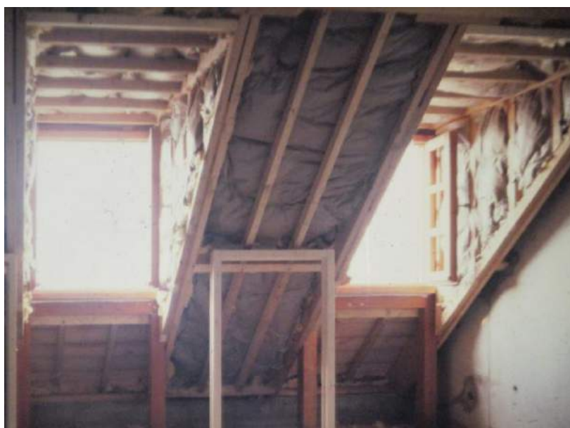
Remonty generalne i modernizacja starych zasobów to front robót dla rzemiosła budowlanego. Fot. PACT ARIM
