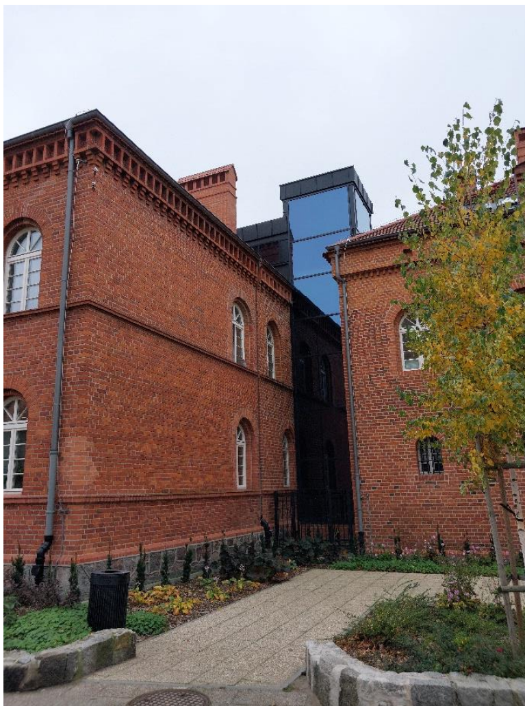
Rysunek 23 Zmodernizowany budynek Miejskiej Biblioteki Publicznej przy ul. Dąbrowskiego 6 w Tczewie
