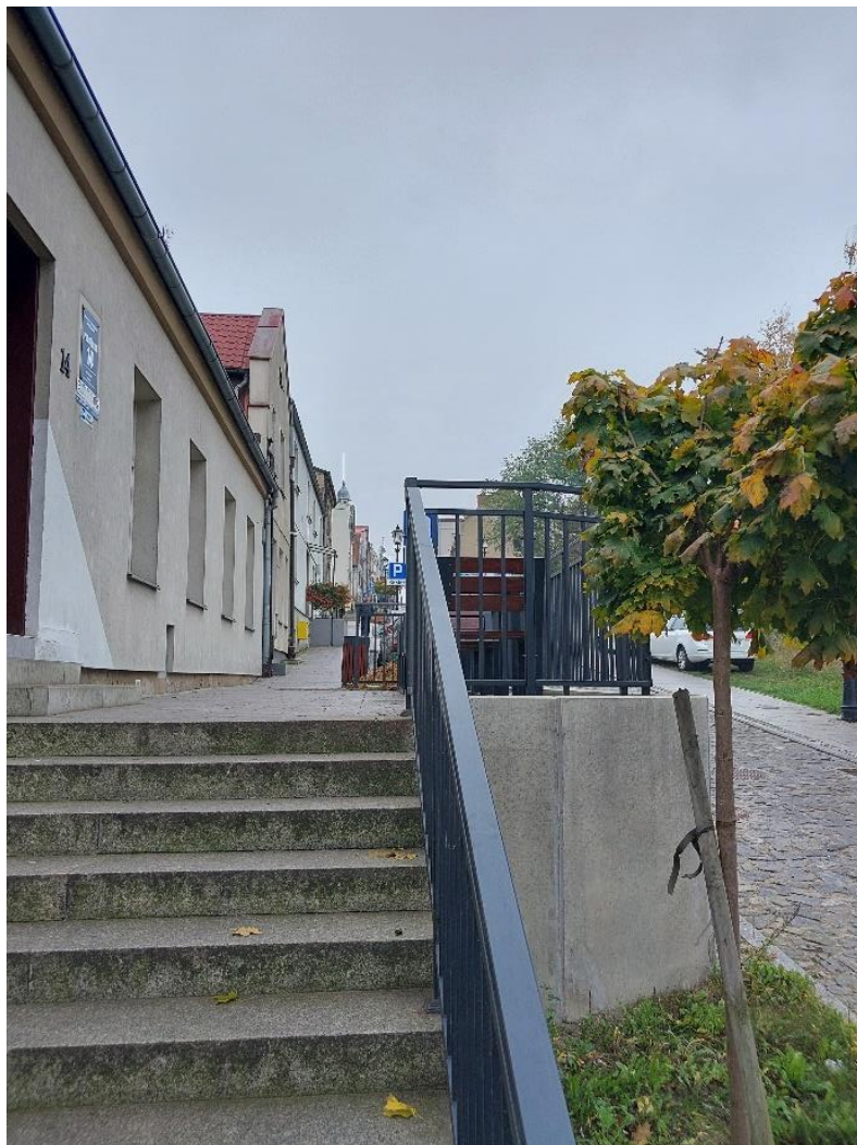
Rysunek 24 Przebudowana ulica Podgórna w Tczewie
